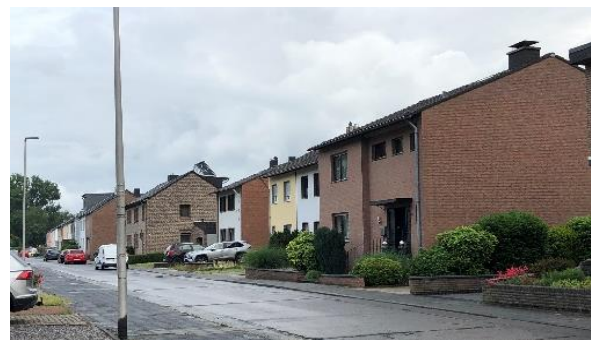
Abb. 38: Uferstraße Quelle: Stadt Jülich (2021)
