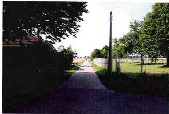
Abb. 53: Vogelbaumweg: sanierungsbedürftig Quelle: Stadt Jülich / Planungsgruppe MWM
