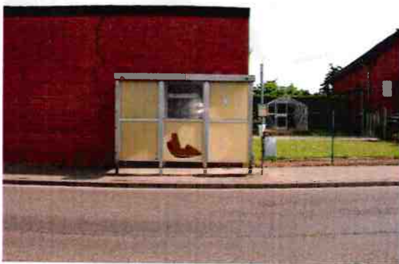
Abb. 52: Bushaltestellen in schlechtem baulichen Zustand Quelle: Stadt Jülich / Planungsgruppe MWM
