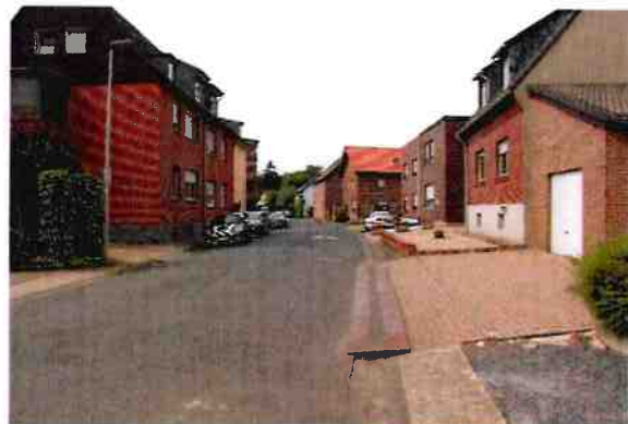
Abb. 125: Kasterstraße: beengter Straßenraum, hohe Verkehrsbelastung, fehlende Gehwege
