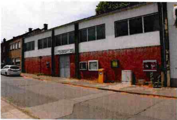
Abb. 155: Bürgerhalle: Sanierungsbedarf, Sanierungsfähigkeit unklar Quelle: Stadt Jülich / Planungsgruppe MWM
