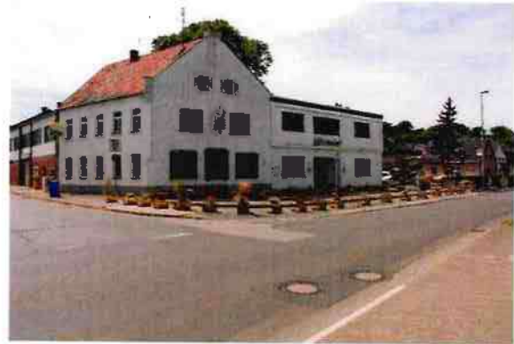
Abb. 154: Linden Hof: fehlende Nachnutzung Quelle: Stadt Jülich / Planungsgruppe MWM
