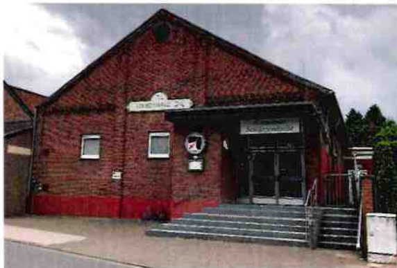
Abb. 193: Sanierungsbedarf Schützenhalle Quelle: Stadt Jülich / Planungsgruppe MWM
